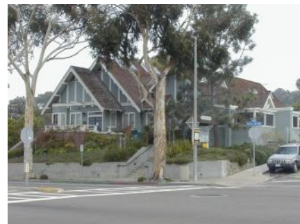
Del Mar Library, 1309 Camino del Mar.
